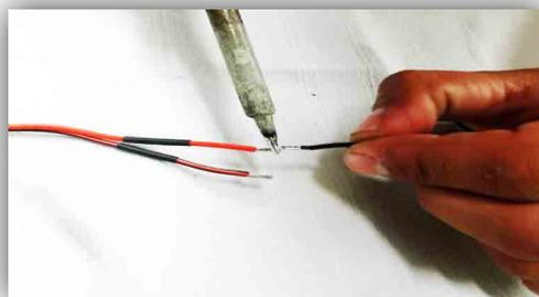
NOTA: Las fundas termocontráctiles se cortarán con tijeras a la medida necesaria para cubrir el empalme y deberán ser del diámetro según el calibre del cable que utilicemos en nuestra instalación.
